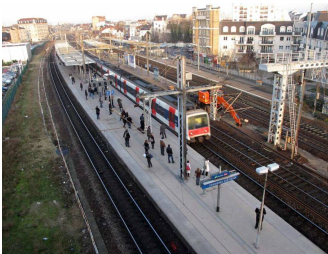
Gare de Houilles - Carrières-sur-Seine (Yvelines). Le projet Eole, qui prévoit l'extension du RER E vers l'ouest, risque de prendre plusieurs années de retard si les fonds initialement prévus n'ont pas été réunis avant l'été. (LP/Laurent Mauron.)
