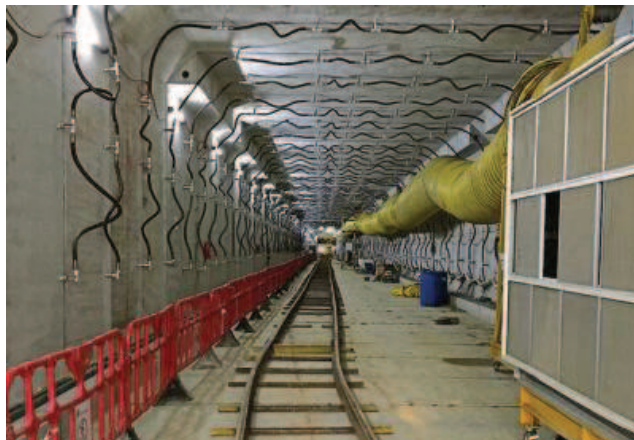
A Singapour, un tunnelier à six têtes foreuses a permis de creuser des tunnels carrés. Photo DR
