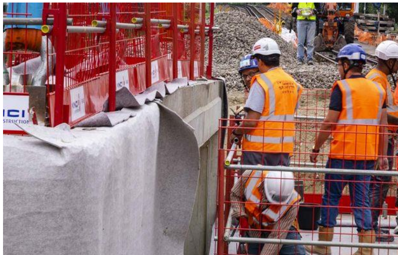
Les modules sont posés côte à côte avec une précision centimétrique.
