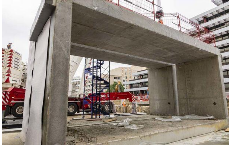
Les modules-cadres ont été préfabriqués sur place.
