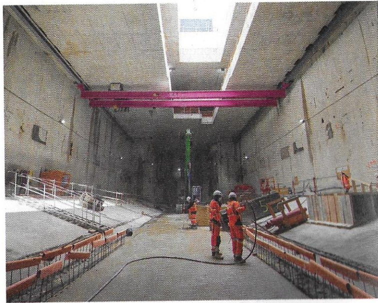
Le tunnelier arrivera à la station Montreuil-Hôpital le 28 octobre.
