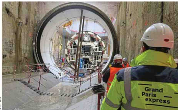
Le budget total de ce chantier gigantesque sera d'au moins 35,6 Mds€.
